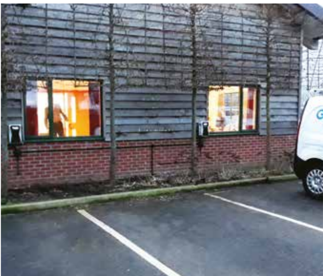
AC charger installato in Regno Unito Modello usato ATESS EVA-11S-S
