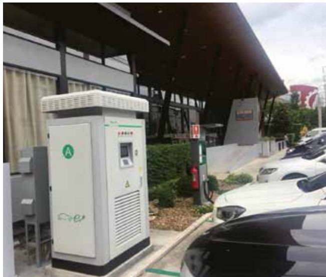
AC charger installato in Italia Modello usato ATESS EVA-11S-P
