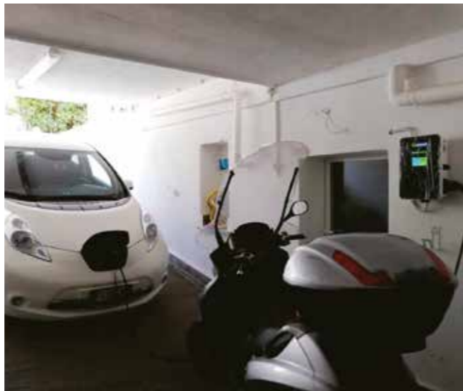
AC charger installato in Italia Modello usato ATESS EVA-11S-P
